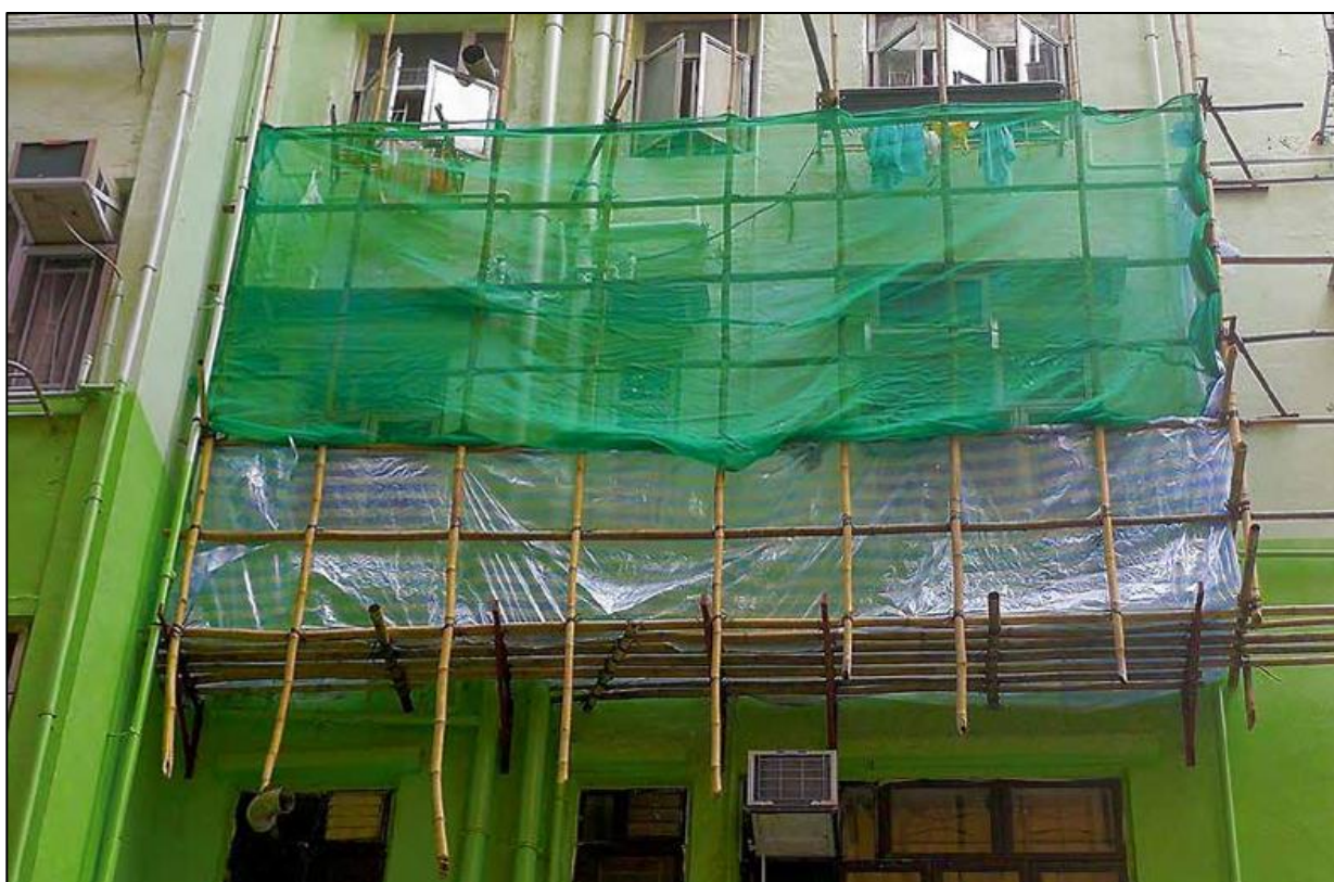
悬空式竹棚架（俗称「吊棚」 / 「飞棚」）
